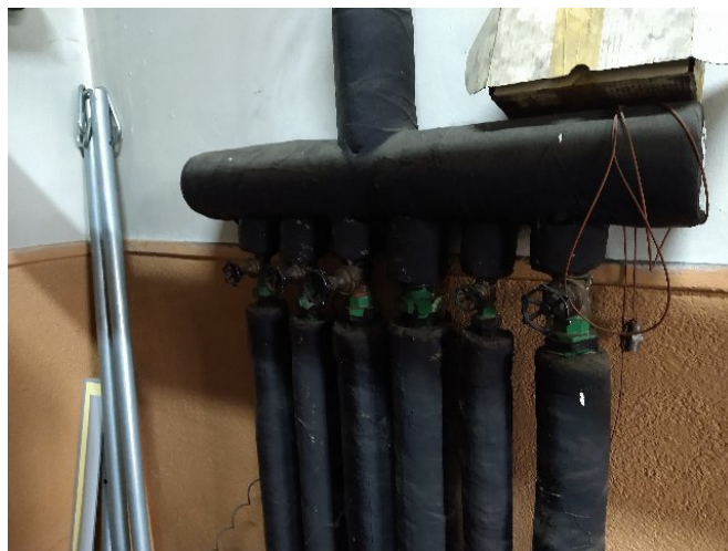
Colector de retorno edificio histórico
