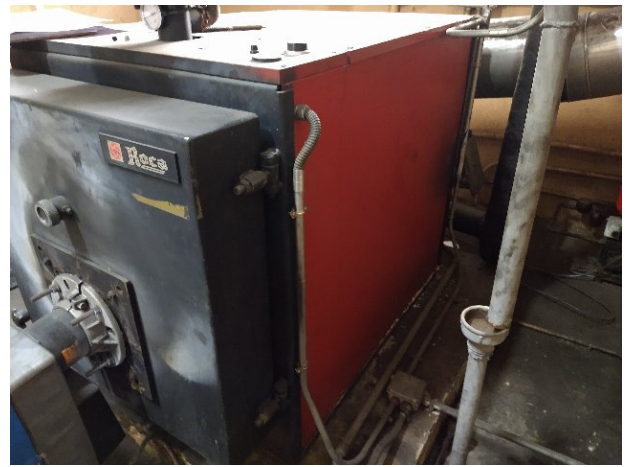
Caldera gasóleo existente en edificio histórico 300 kW
