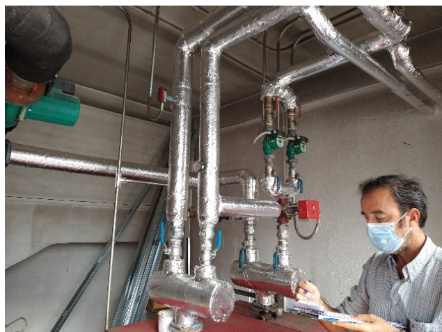
Colectores hidráulicos en sala de calderas Edificio Laboratorio con circuitos para propio laboratorio y edificio nuevo
