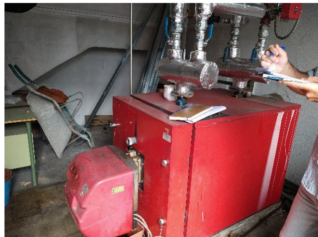
Caldera gasóleo existente sala calderas en Edificio Laboratorio 205,8 kW
